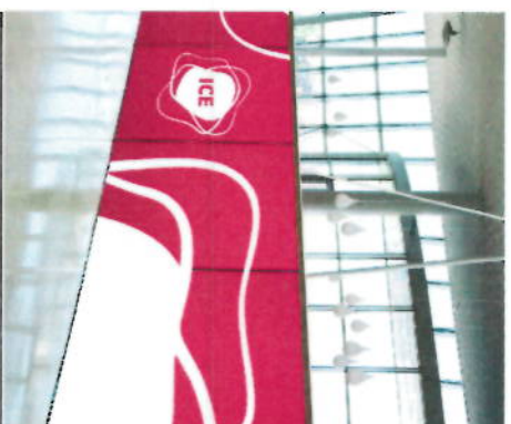
01 Wyklejenie szklanych balustrad
