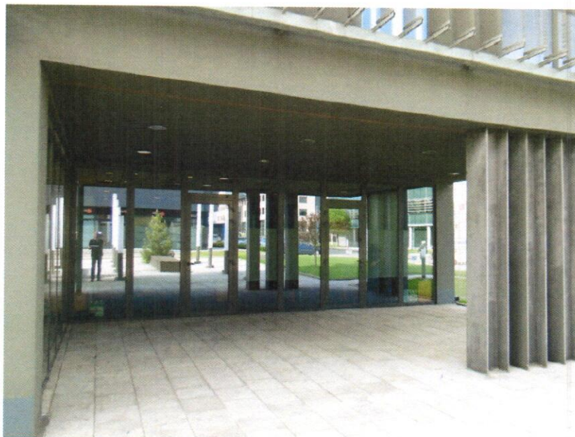
Zdjęcie nr 7: Podcień budynku do malowania.
