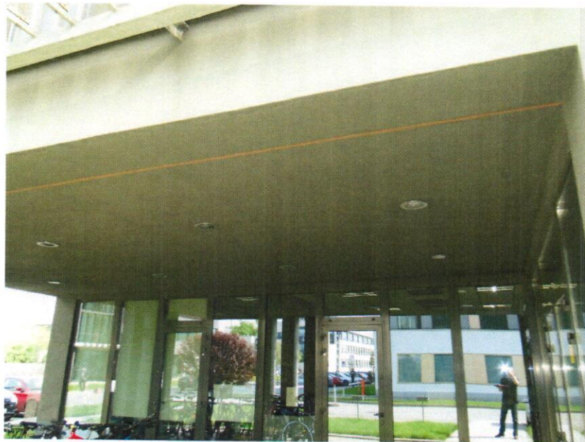
Zdjęcie nr 6: Podcień budynku do malowania.
