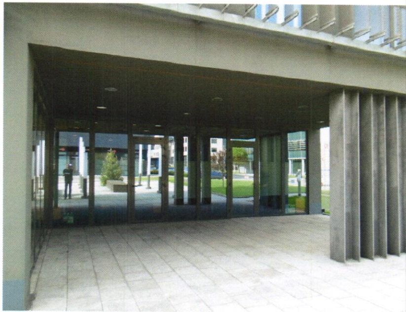
Zdjęcie nr 7: Podcień budynku do malowania.
