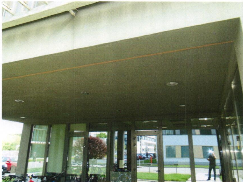
Zdjęcie nr 6: Podcień budynku do malowania.
