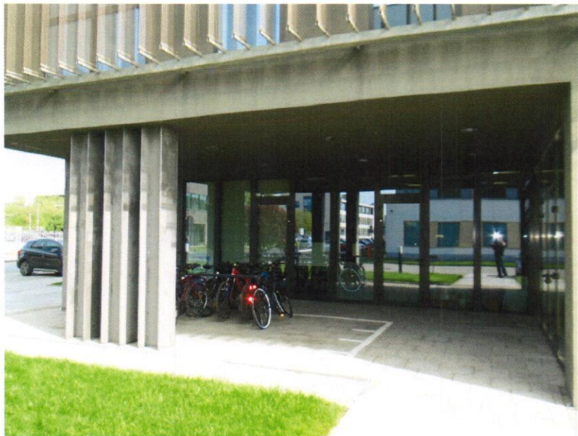
Zdjęcie nr 5: Podcień budynku do malowania.
